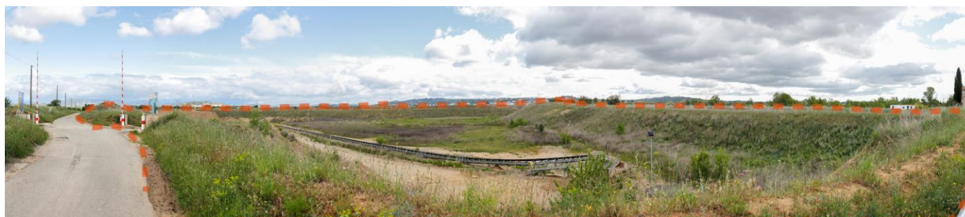
Figure 1 : Emprise de la zone d'étude faisant apparaître les excavations et les variations du relief
